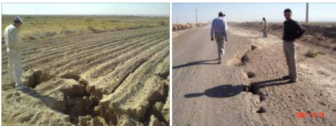
شکل ۱۷: نمونه از آسیب شکاف‌ها ناشی از نشست زمین در جاده و زمین‌های کشاورزی دشت نیشابور
