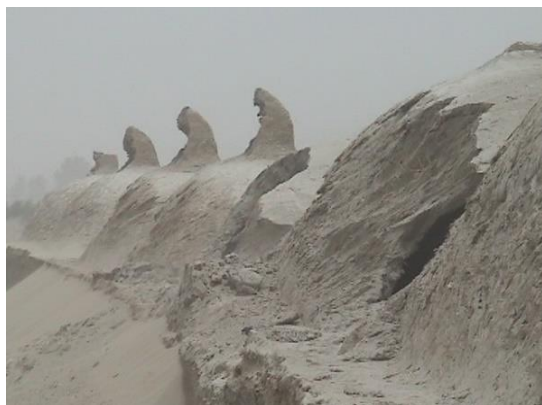
شکل ۱۵: سایش سقف مسکن بومی توسط ماسه‌ها
