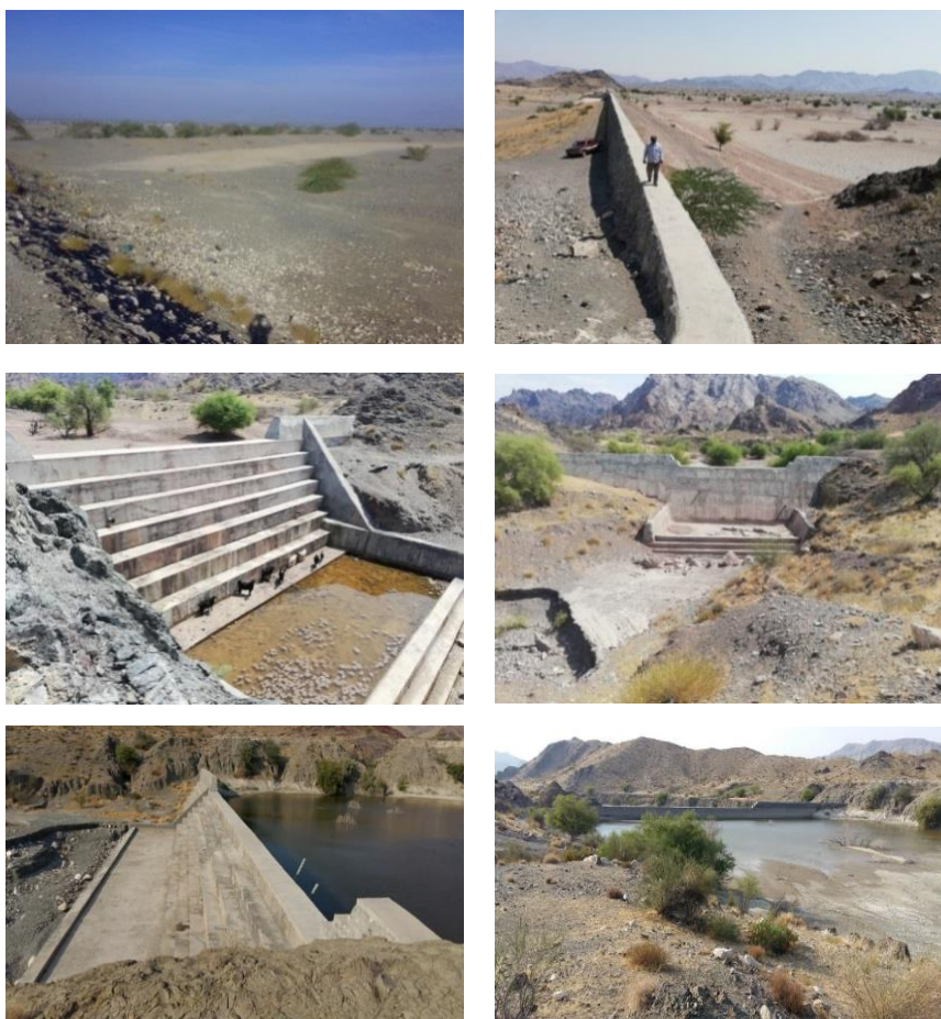
شکل ۲. برخی از سازه‌های موجود در حوزه
